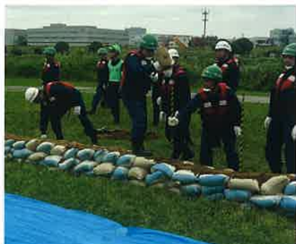
積み土のう工法
